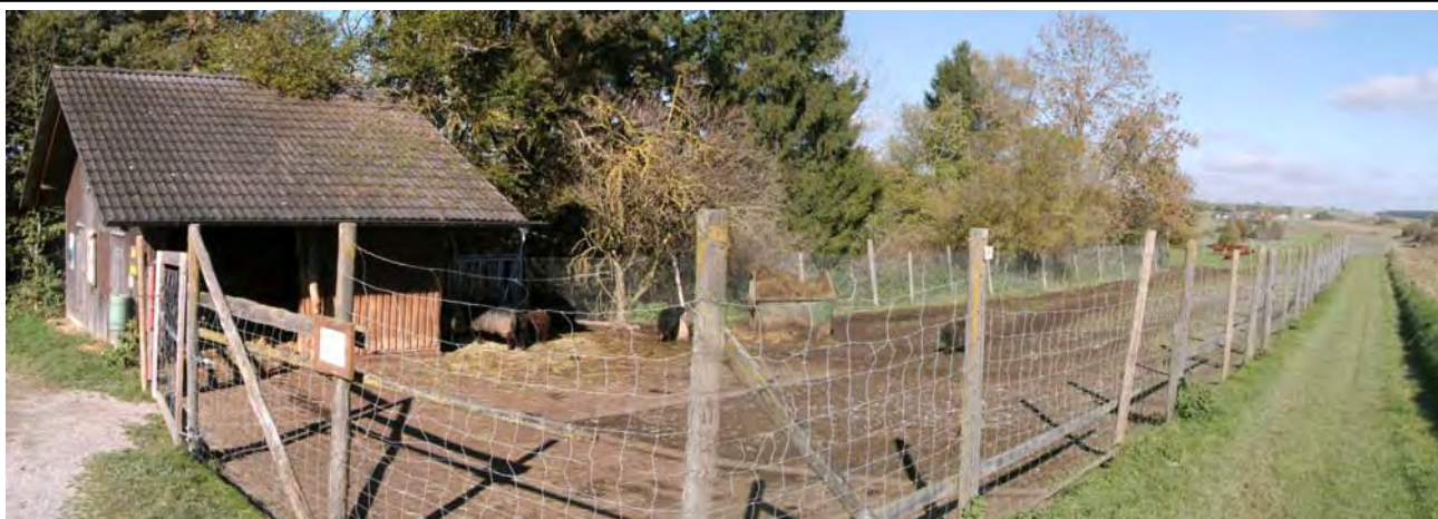
bestehendes östliches Stallgebäude
