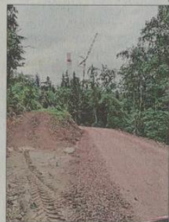
Der Windpark Hohenlochen auf der Zielgeraden. Foto: Badenova
