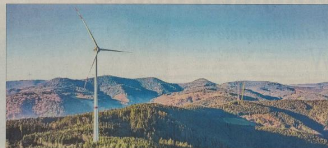
Auf dem Hohenlochen wird zur Zeit ein Windpark errichtet. Vier Windräder sollen dort Energie gewinnen. Archivfoto: Andreas Walny
